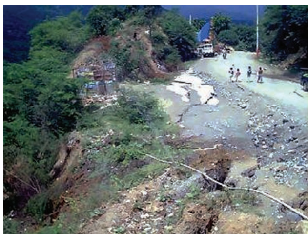
Foto 5. Deslizamiento Carretera de Ocoa.
