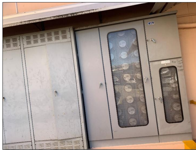
Imagen No. 75. Módulo de contadores del IEM.
