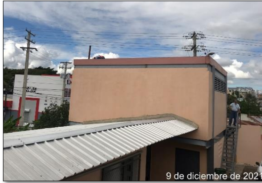
Imágenes No. 76 y 77. Caseta Insonorizada para los Generadores Eléctricos.
