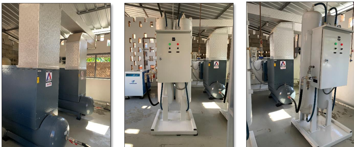
Imágenes No. 54 – 56. Equipos utilizados para la generación de oxígeno en el IEM.
