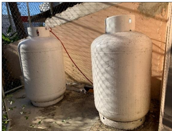
Imagen No. 88. Cilindros de Gas Licuado de Petróleo con capacidad de 100 galones c/u. Se utilizan para las secadoras de la lavandería y para la cocina.
