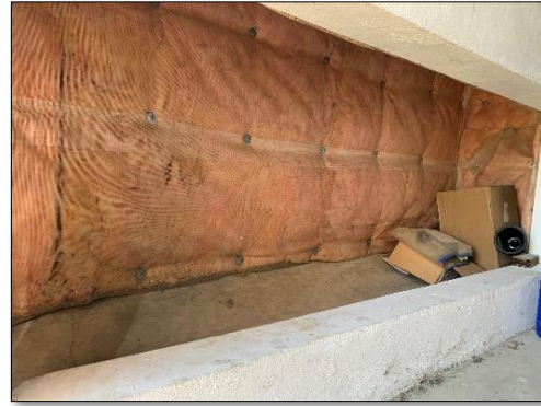
Imágenes No. 76 y 77. Caseta Insonorizada para los Generadores Eléctricos.
