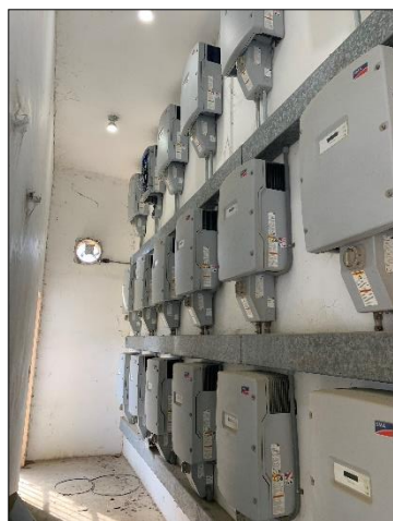
Imágenes No. 84 y 85. Cuarto de inversores para los paneles solares.
