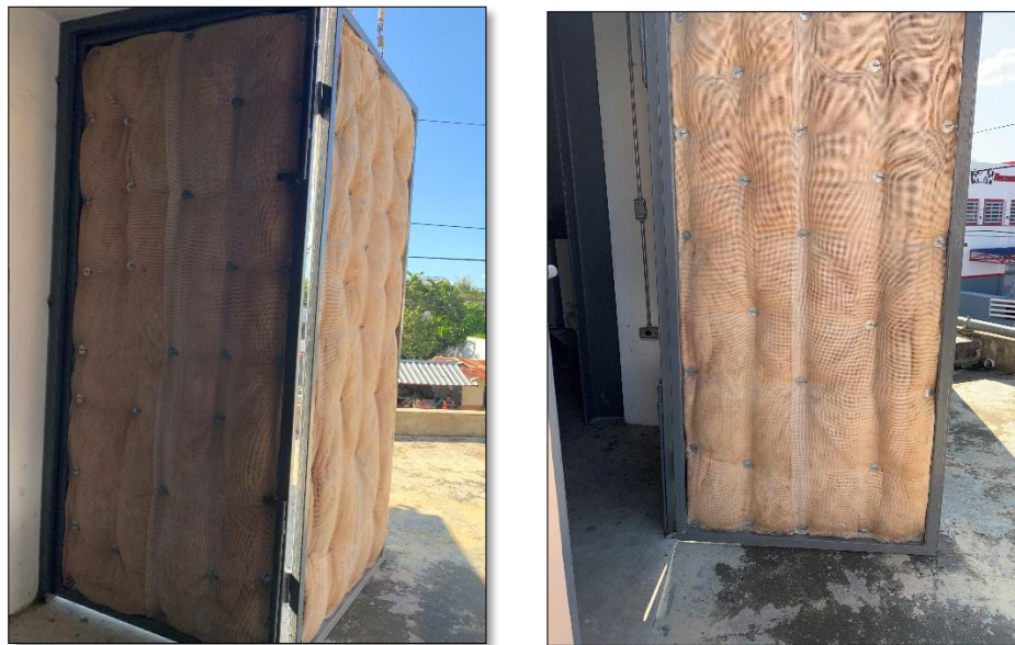
Imágenes No. 117 y 118. Caseta de generadores eléctricos Insonorizada.
