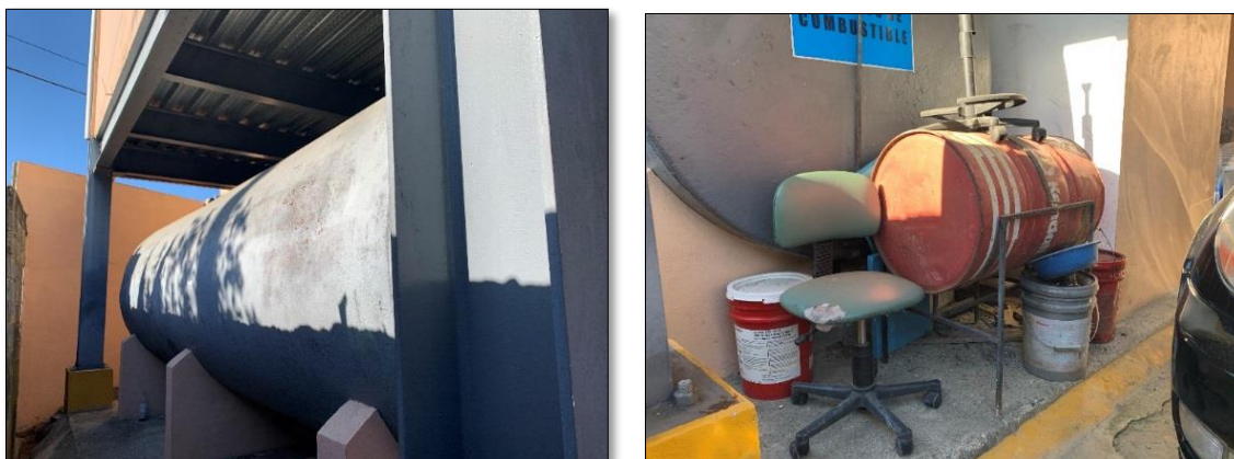
Imágenes No. 86 y 87. Almacenamiento de combustible diésel.
