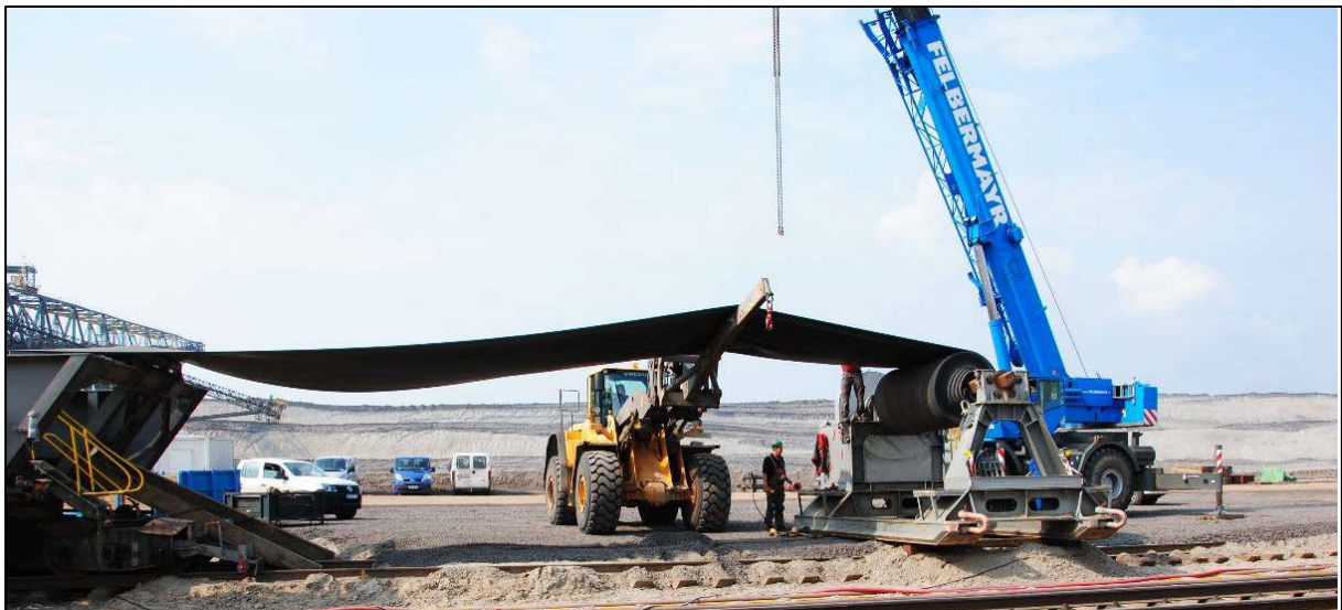
Figura 1.30: Desmantelamiento de correa transportadora y enrollado en tambor de traslado
