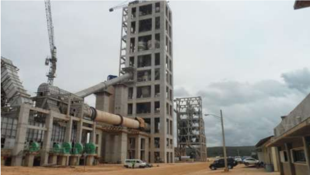
Foto No.2. Antiguas instalaciones de Cemento Andino, Cabo Rojo (Fuente: Acoproví)
