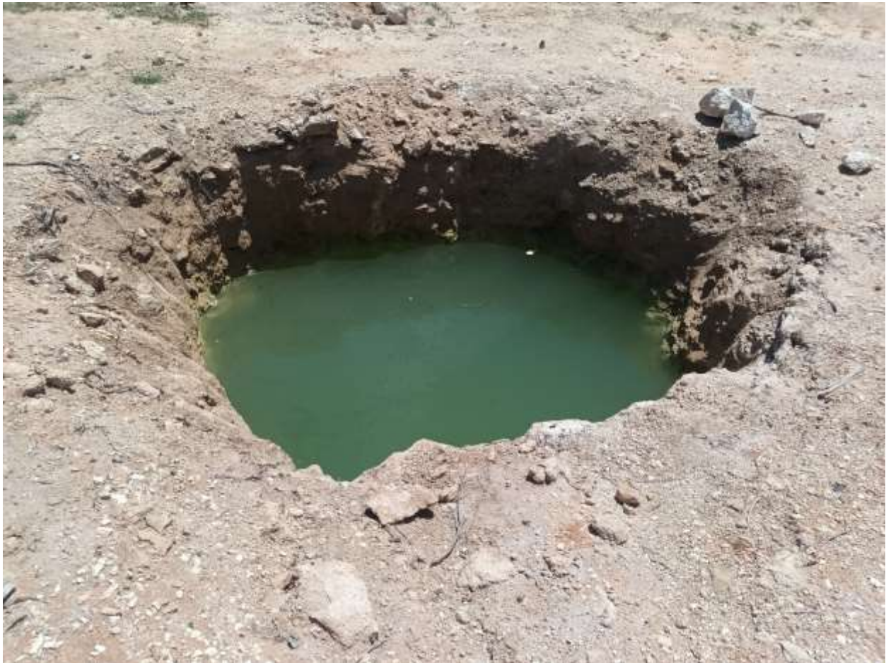
Foto No.6. Imagen de una de las calicatas perforadas en la periferia del proyecto, nótese el tipo de suelos, el nivel freático con agua dulce a menos de 0.80 m.
