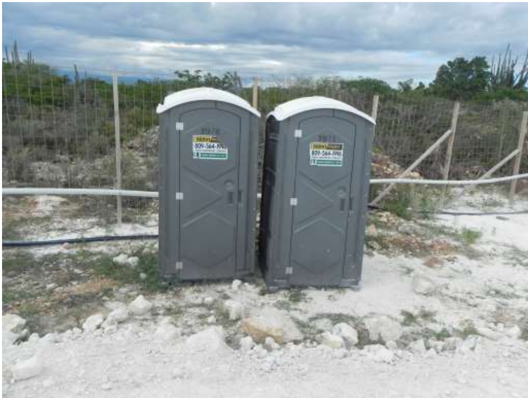
Foto No.4. Baños portátiles ubicados en diferentes áreas de la construcción
