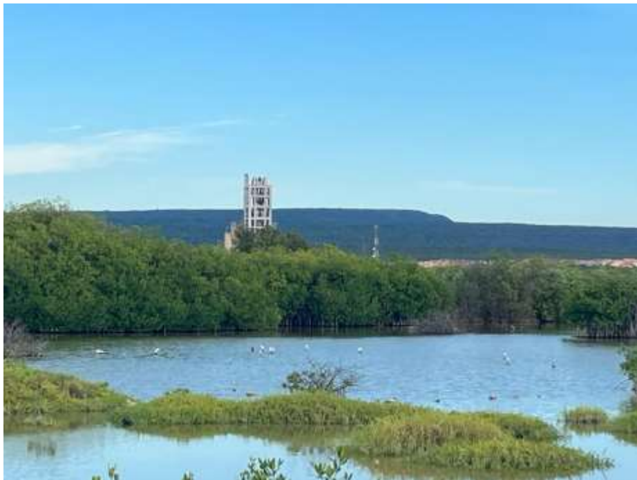
Foto No.23. Edificación abandonada por la planta de fabricación de cemento, entre humedal y farallón
