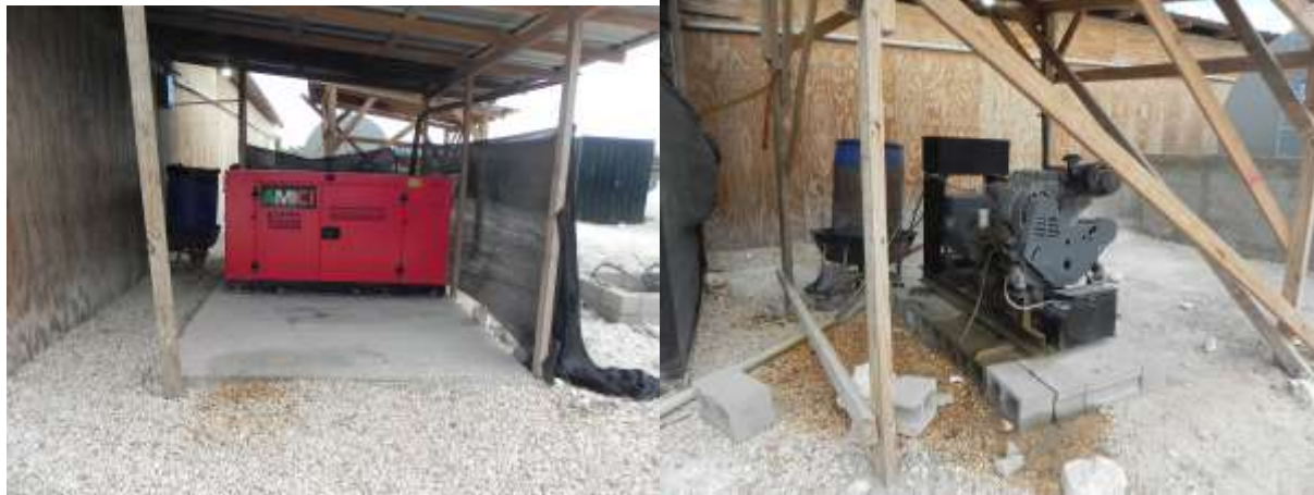
Foto No.5. Dos de los generadores que operan en la fase de construcción
