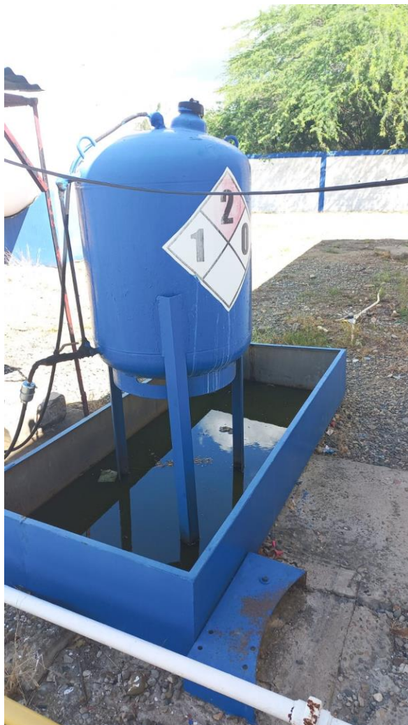
Foto Tanque de diesel de la motobomba + extontor en área de GLP.
