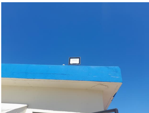
Foto 6.7-2. Utilización de lámparas de iluminación exterior con fotoceldas en las instalaciones del proyecto (tomada el 2 de marzo de 2023).
