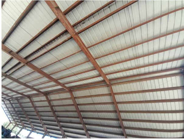
Fotos 1.3.2.1-1. Vistas de techos de Aluzinc y pisos de hormigón pulido en las naves de procesamiento de Madex Recycling, S.R.L. (tomadas el 2 de marzo de 2023).
