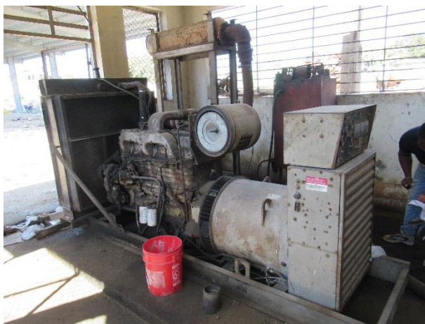
Foto 4.5-1. Mediciones de la concentración de gases de combustión en las emisiones de la chimenea del generador de electricidad de emergencia (230 kW). Tomada marzo 2023,
