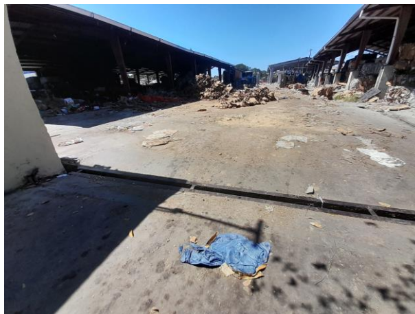
Fotos 1.8.5-1. Rejillas de captación para la conducción de aguas pluviales dentro de la empresa (tomadas el 2 de marzo de 2023).
