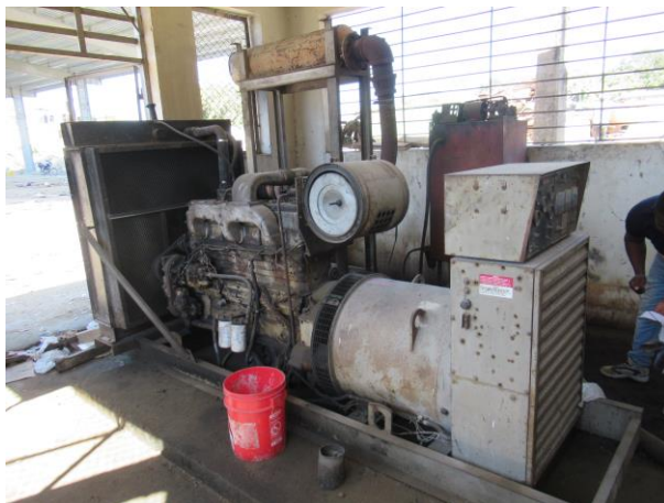
Foto 1.8.1-1. Generador de electricidad de emergencia emplazado en base de hormigón para minimizar las vibraciones en la estructura de la edificación (tomada el 2 de marzo de 2023).
