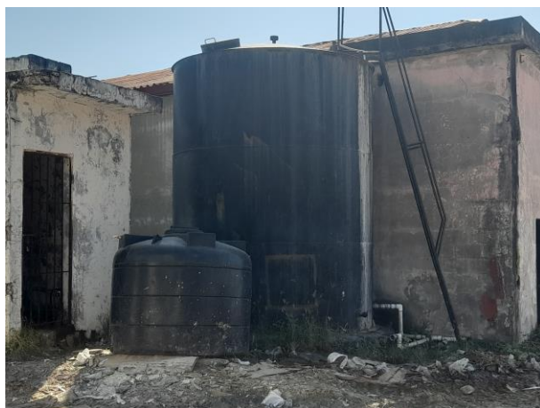
Fotos 1.8.3-1. Pozo de abasto y cisterna de almacenamiento de las aguas del sistema contra incendios (tomadas el 2 de marzo de 2023).
