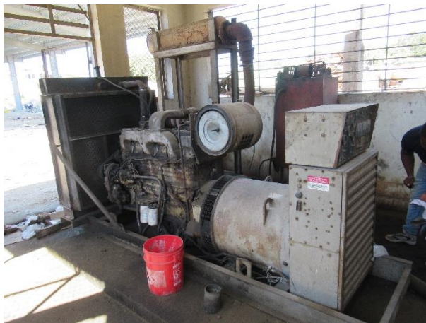
Foto 6-1. Mediciones de la concentración de gases de combustión en las emisiones de la chimenea del generador de electricidad de emergencia (230 kW).
