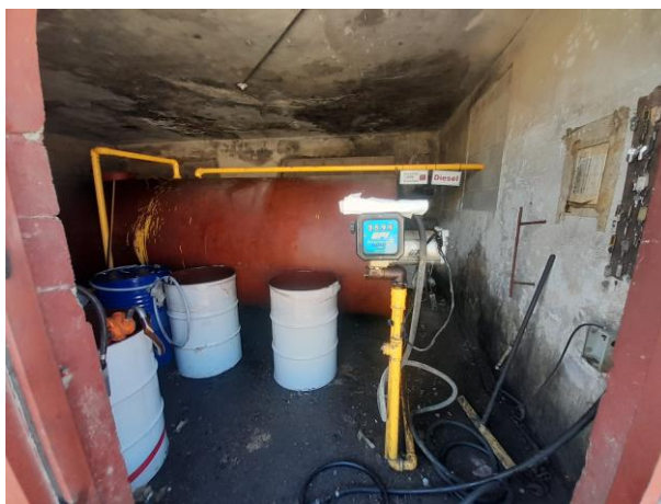
Foto 1.8.1-2. Tanque de almacenamiento de combustible diésel de la empresa (tomada el 2 de marzo de 2023).
