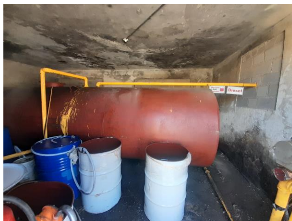
Fotos 1.3.2.6-1. Tanque de almacenamiento de combustible diésel (tomadas el 2 de marzo de 2023).
