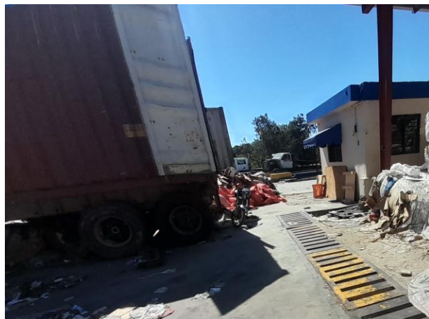
Fotos 1.8.5-1. Rejillas de captación para la conducción de aguas pluviales dentro de la empresa (tomadas el 2 de marzo de 2023).
