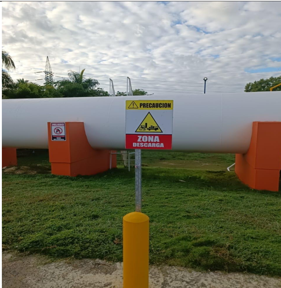
Tanque de almacenamiento de GLP
