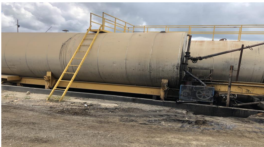
Foto No. 7.- Tanque de almacenamiento de AC-30, con su muro de contención
