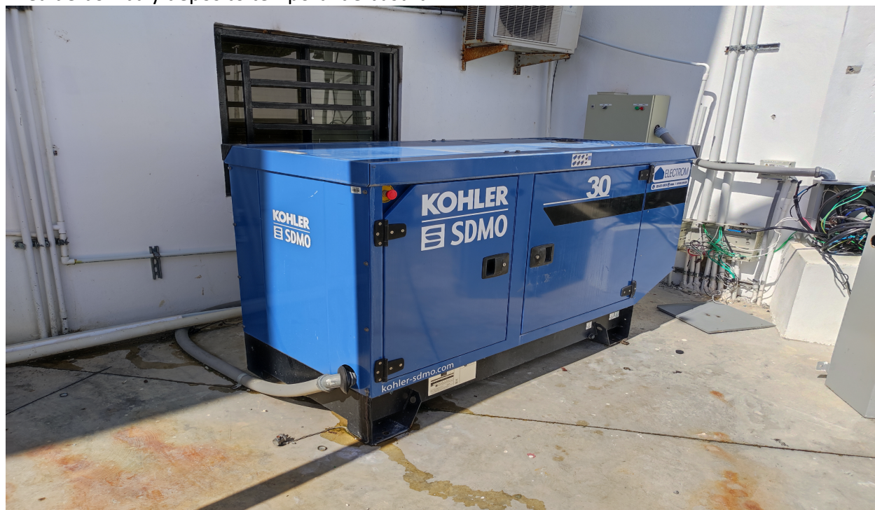
Area de generador/generador encapsulado
