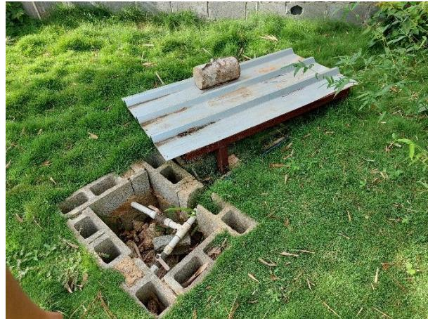
**Foto 1.2.2..2.8.3-1.** Pozo de extracción de agua potable.
