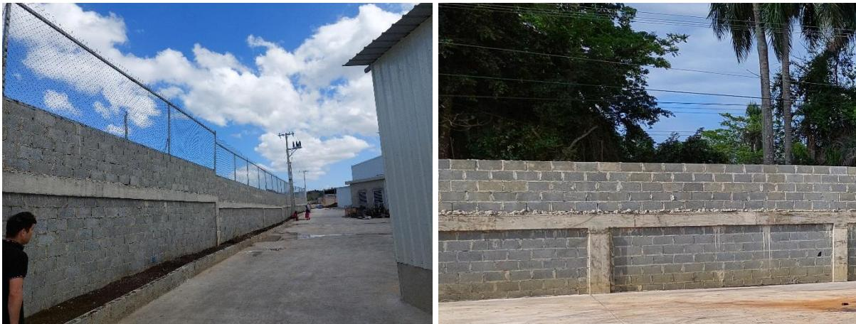
**Fotos 1.2.2.2.7-1.** Cercado perimetral del proyecto construida en bloques de hormigón.
