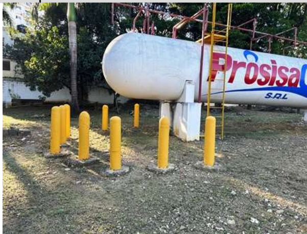
Imagen del Tanque estacionario con soportes de muros de hormigón.
