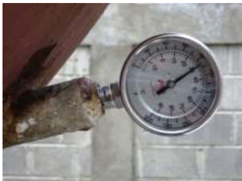
Modelo de medidores de presión colocados en el tanque de almacenamiento de la envasadora
