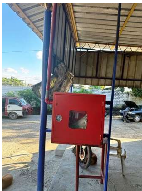
Gabinete contra incendio en la instalación
