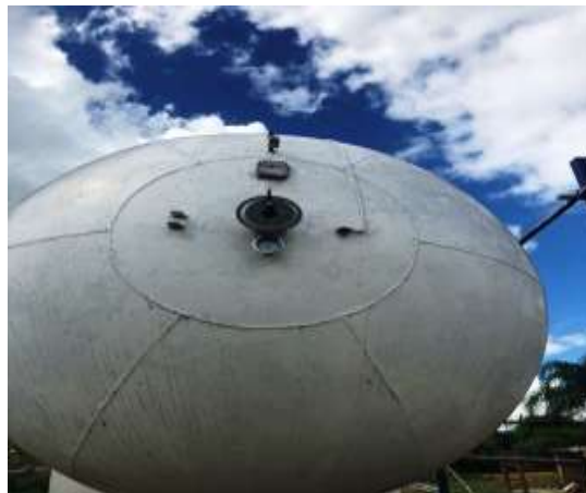
Modelo de medidores de presión colocados en el tanque de almacenamiento de la envasadora
