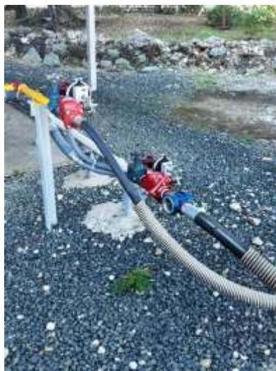
Válvula para el llenado del Tanque Estacionario desde el suplidor.
