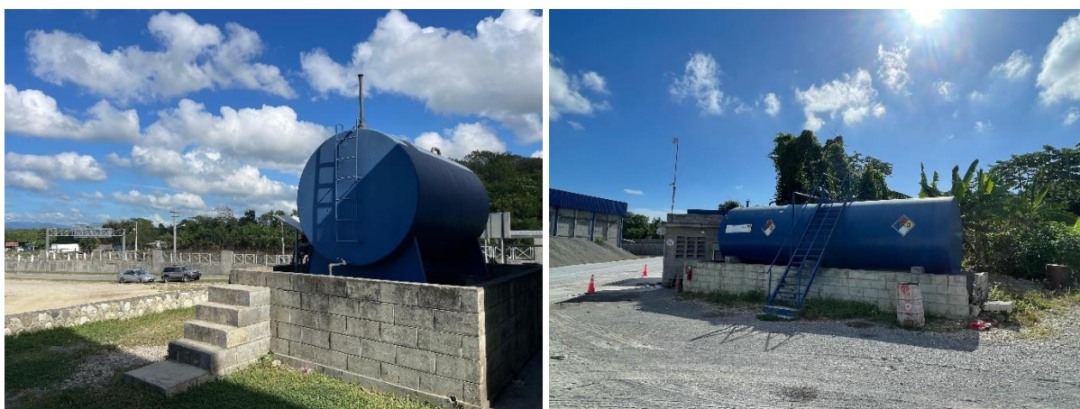
Imagen 47 Tanques de almacenamiento de Diesel
