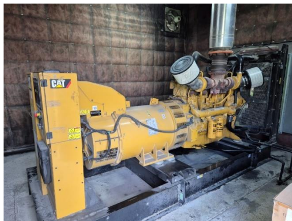
Imagen 23 Grupo electrógeno de emergencia
