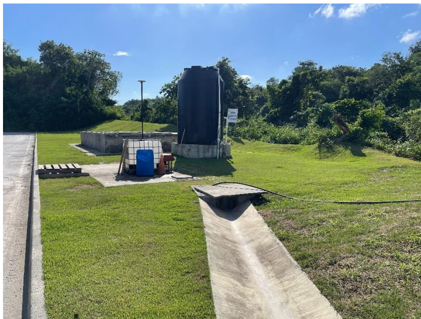
Imagen 26 Sistema de retrofiltración lenta para reúso del agua residual industrial tratada
