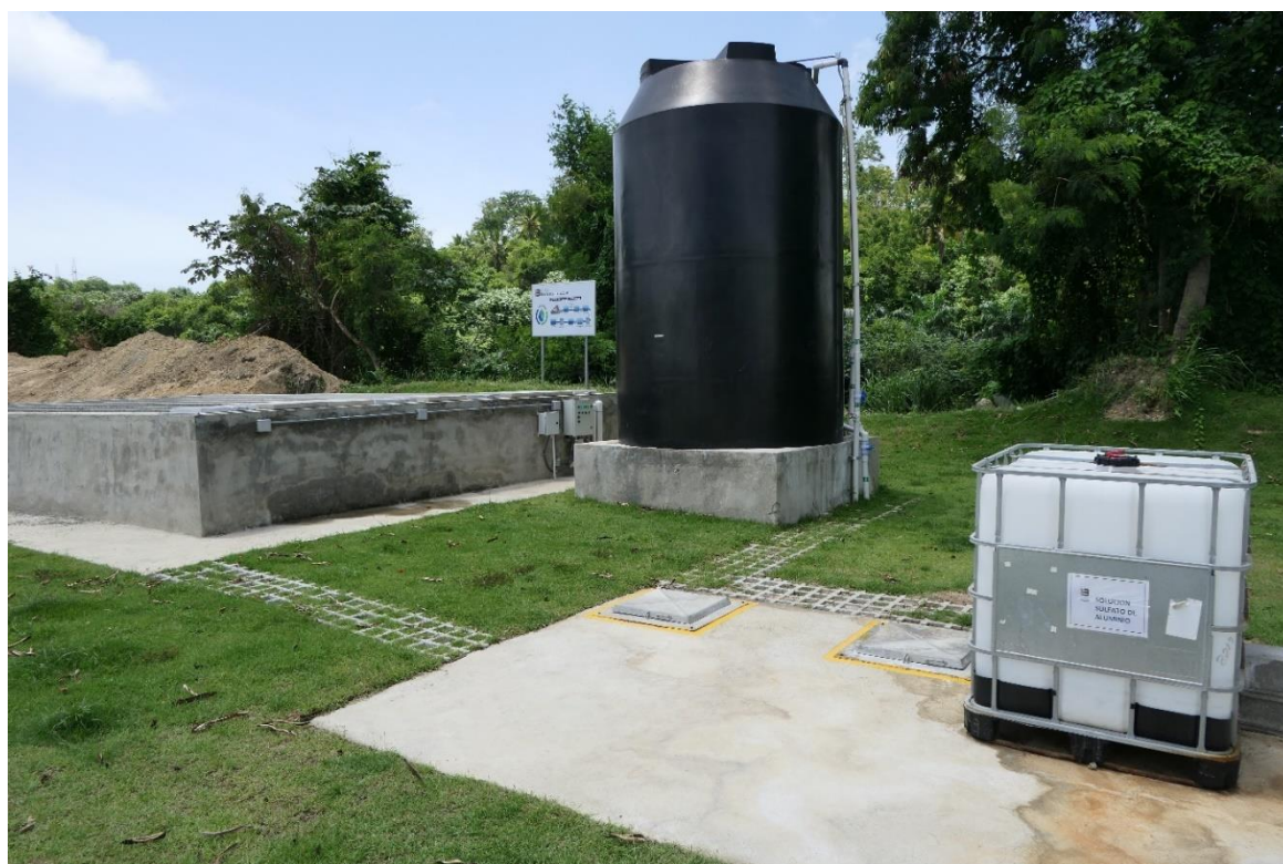
Imagen 38 Sistema de retrofiltración lenta para tratamiento y reutilización de las aguas residuales industriales
