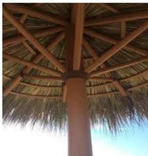
Figura 48 Poste y Estructura de Madera de Palapa
