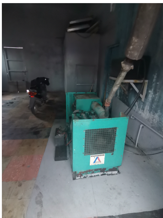
Fotos: Generador electrico
