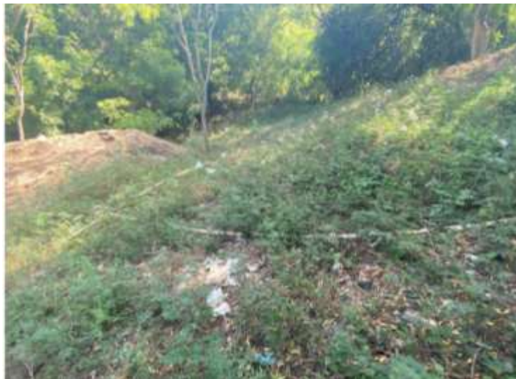
Figura No. 38.- Tuberías para abastecimiento de agua.
