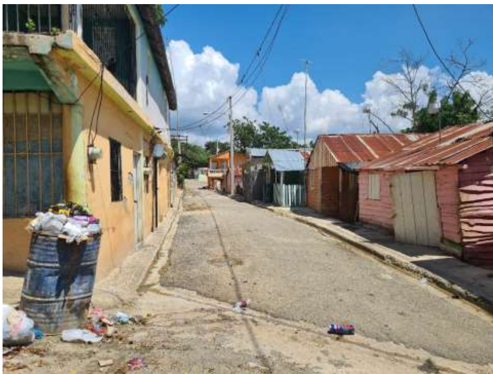
Contenedor de Basura y condición de la calle.
