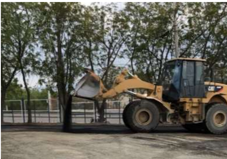
Figura No. 17.- Pala mecánica.
