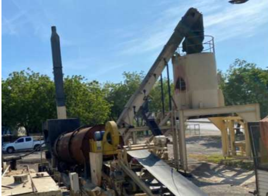
Figura No. 9.- Silo de almacenamiento de asfalto.
