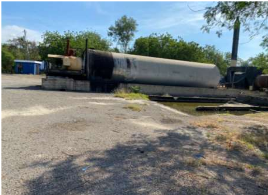
Figura No. 13.- Tanque de almacenamiento de AC-30.
