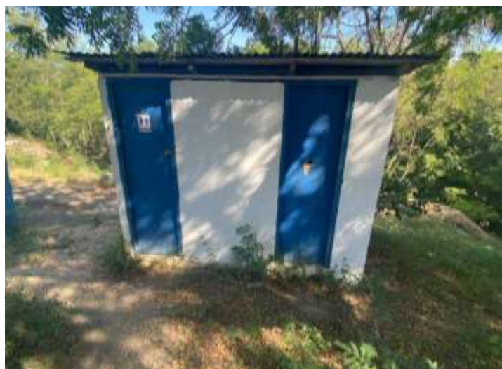
Figura No. 4.- Baños.
