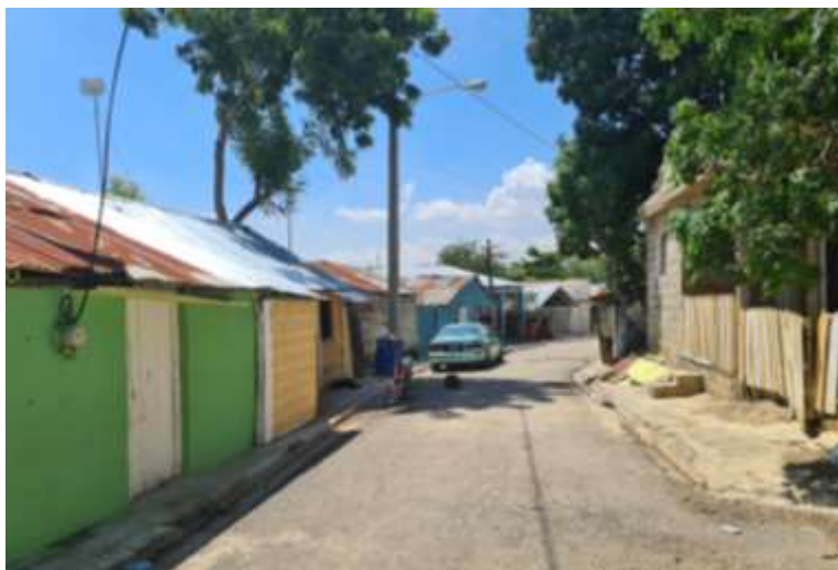
Figura No. 34.- Viviendas y tendido eléctrico.
