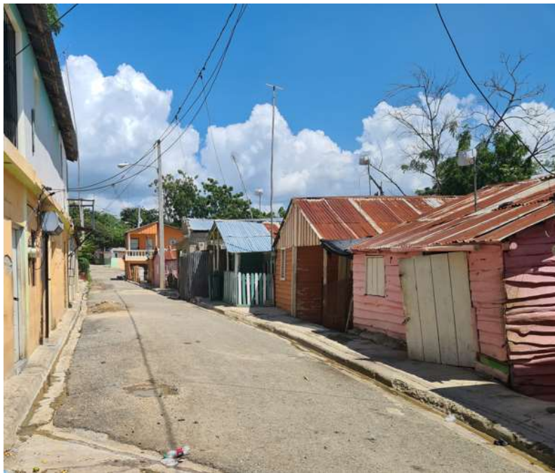
Figura No. 33.- Viviendas en maderas y bloques.
