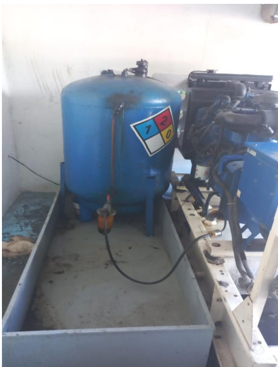
Area de tanque diesel con bandeja
