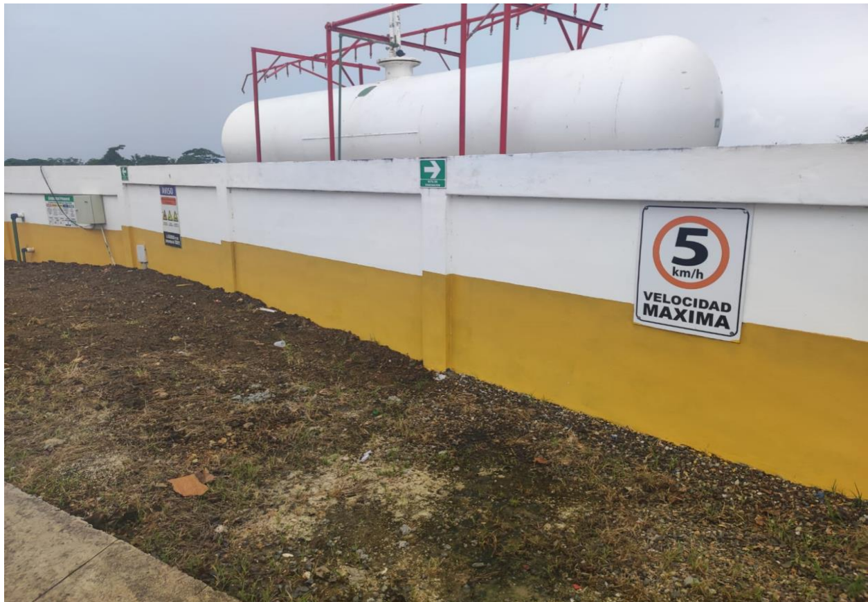
Foto Area de tanque de GLP
