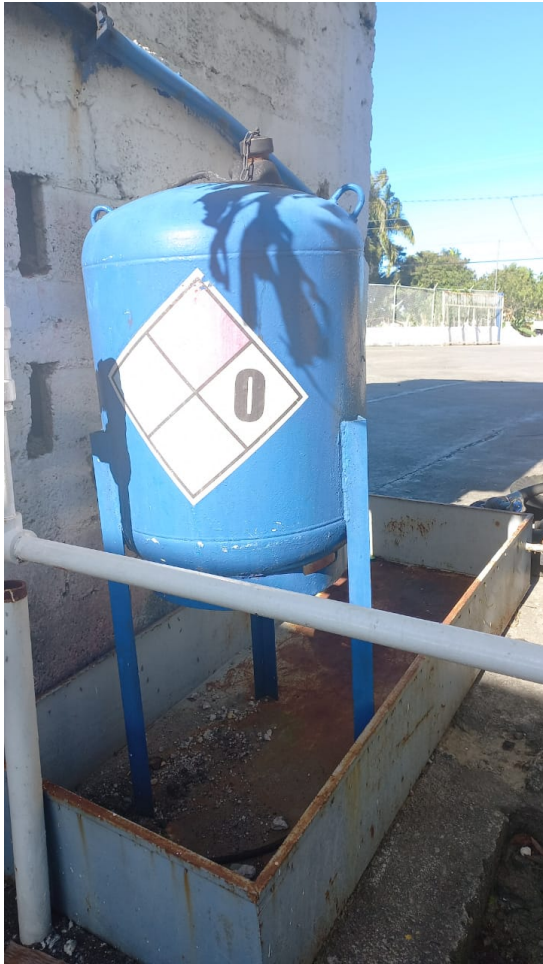
Tanque diesel del generador con bandeja de proteccion contra derrames.
