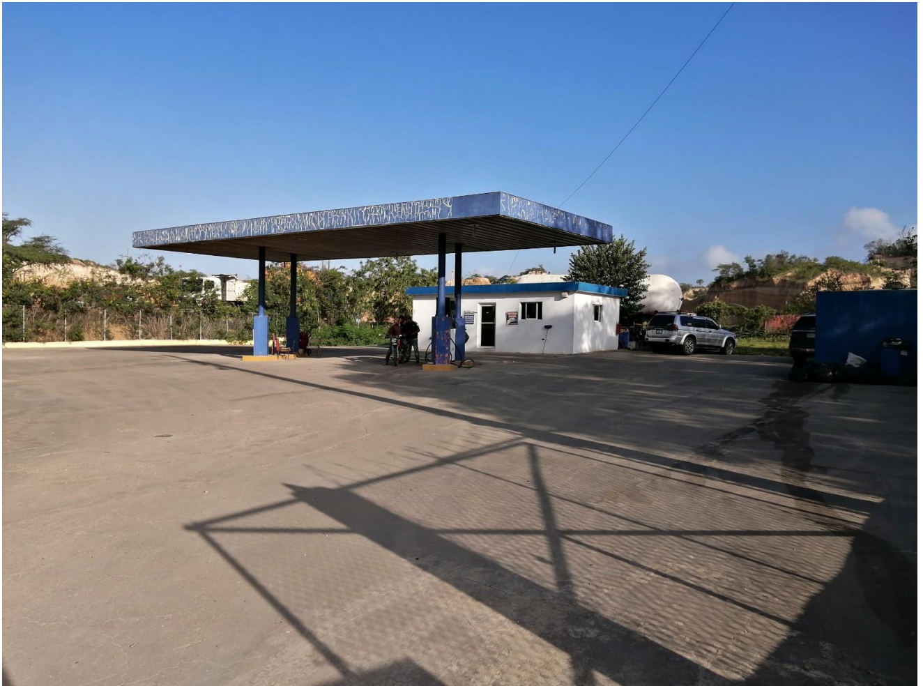
Vista general de las envasadora y sus componentes que dan servicios.
