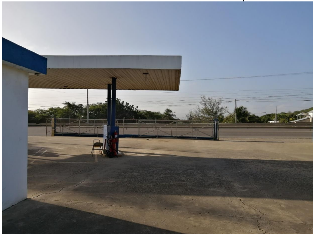
Vista hacia la autopista desde la envasadora.
