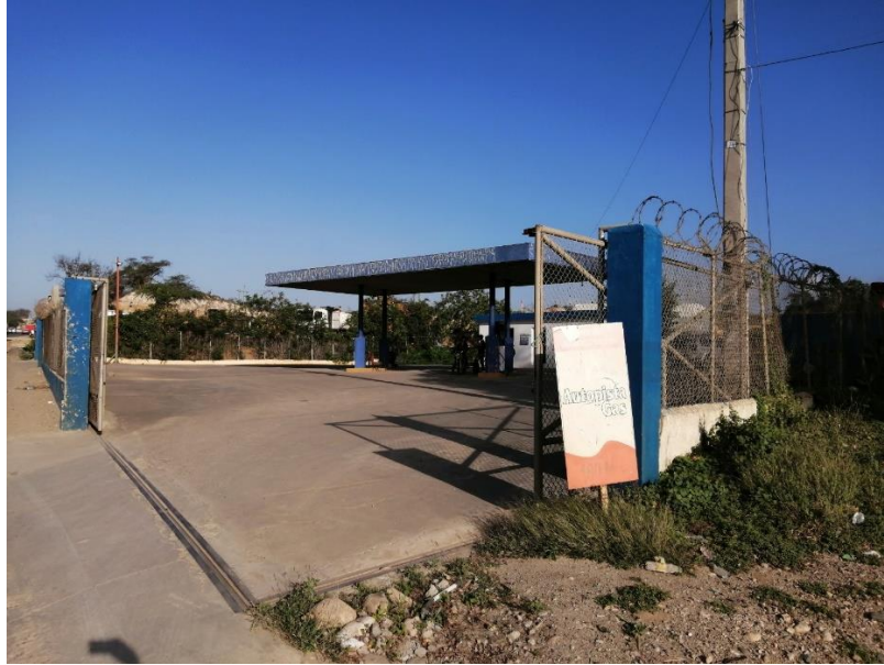
Vista del acceso a la envasadora desde la autopista.
