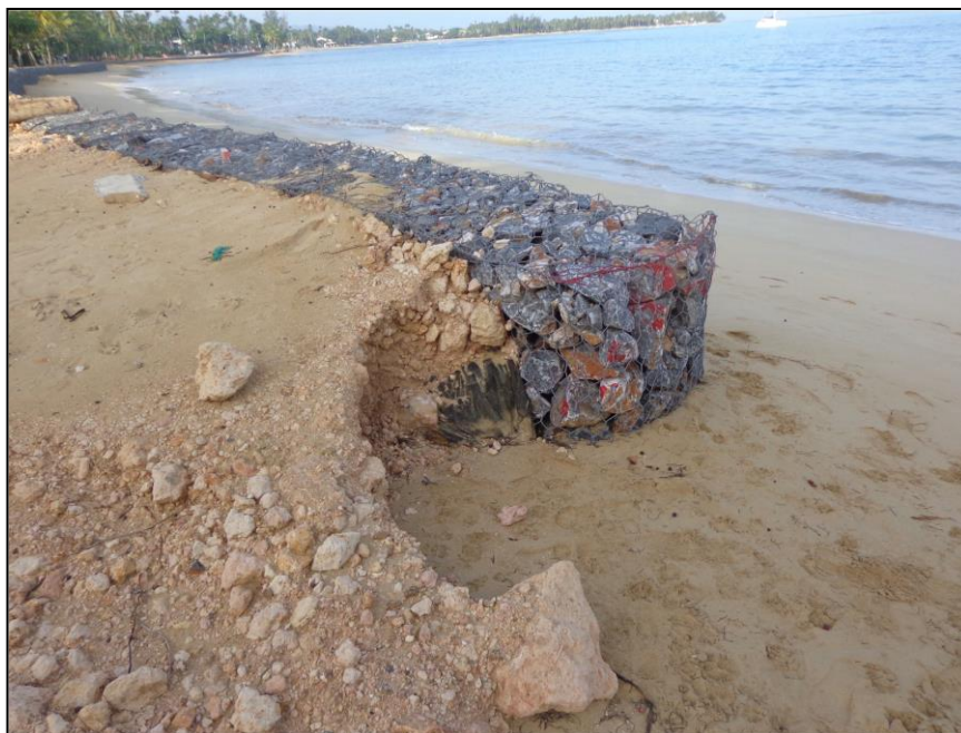
Imagen 2.9 Construcción de muro de gavión para control de erosión en el área de playa de Las Terrenas.
