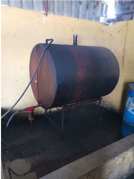
Fotos: Tanque de combustible del generador en muro de contencion + Dispensador de combustible.
