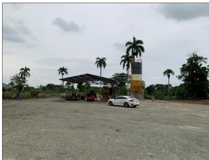
Imagen No. 4. Terreno propuesto para la construir el proyecto.
