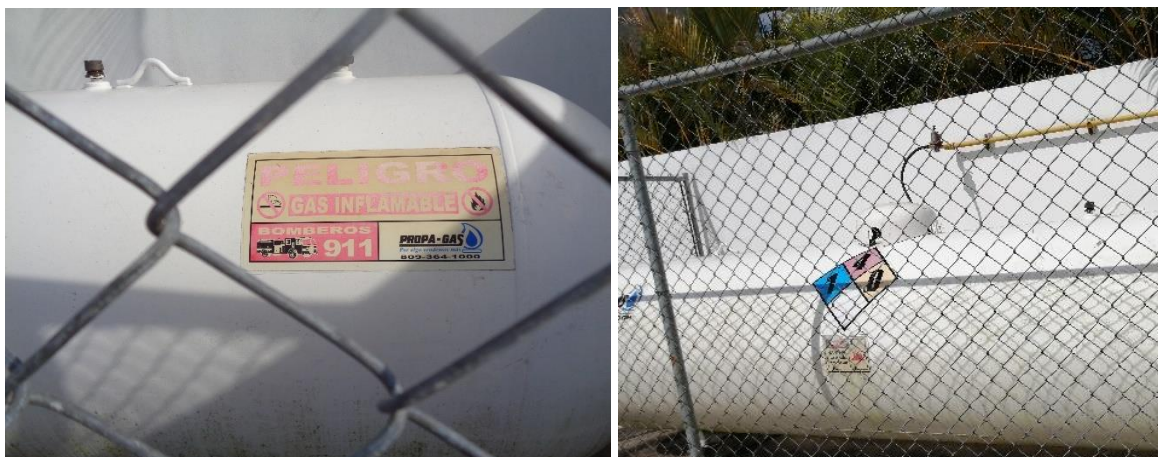
Fotos 5.5-1. Ejemplo de un tanque de almacenamiento de combustible señalizado.
