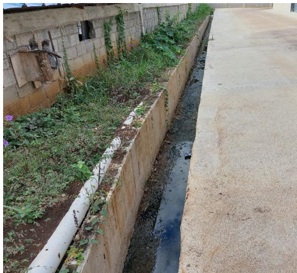
Foto 1.2.2.8-1. Conducción del agua pluvial hacia su filtración al subsuelo.
