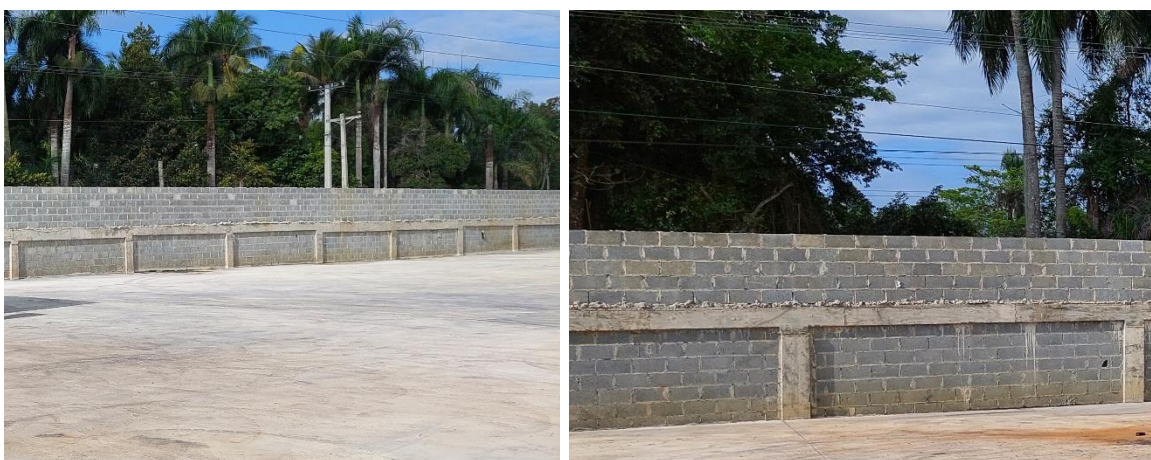
Fotos 1.2.2.3-1. Cerca perimetral del proyecto Sonsoles Aceros, S.R.L., construida en bloques de hormigón.
