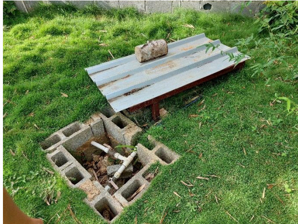
Foto 1.2.2.6-1. Pozo de extracción de agua potable.
