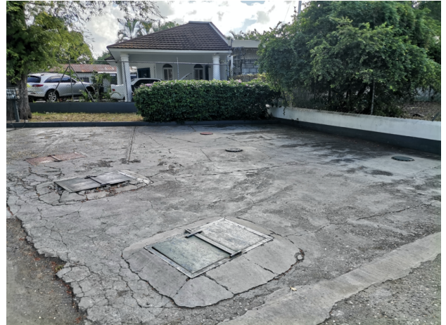
Foto Area de tanques
