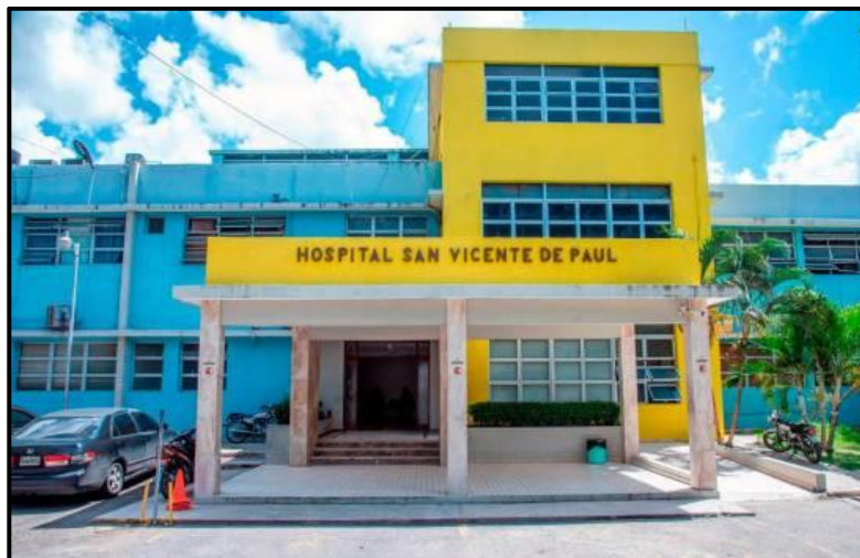
Foto # 45.- Vista del Hospital San Vicente de Paul
