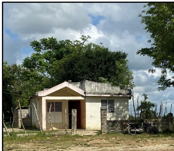
Fotos # 17 y # 18. - Vistas de las dos viviendas más cercanas al sitio del proyecto
