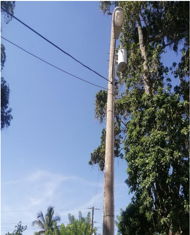
D6. Compresor eléctrico
