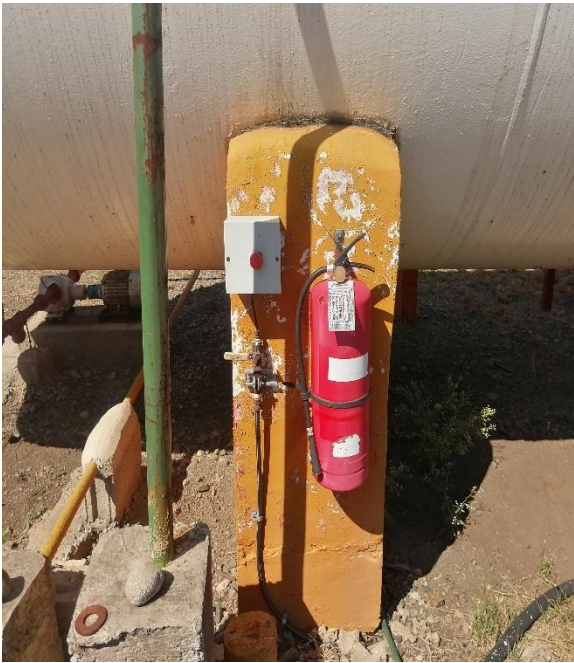
B5. Extintor con botonera cerca al tanque
