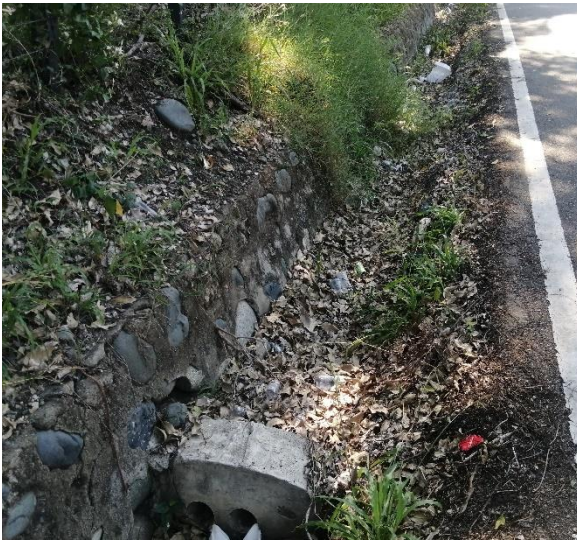
C4. Descarga Tubería drenaje pluvial a la calle
