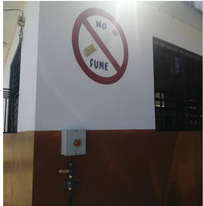
B2. Botonera emergencia y señalización
