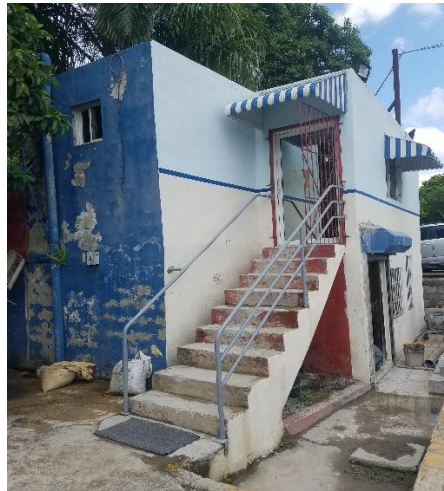
Foto 2. Oficina Gold Concrete.
