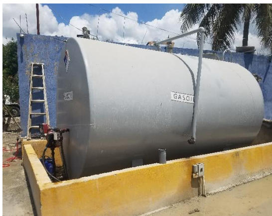
Foto F4-1. Berma en el área de tanque de combustible.
