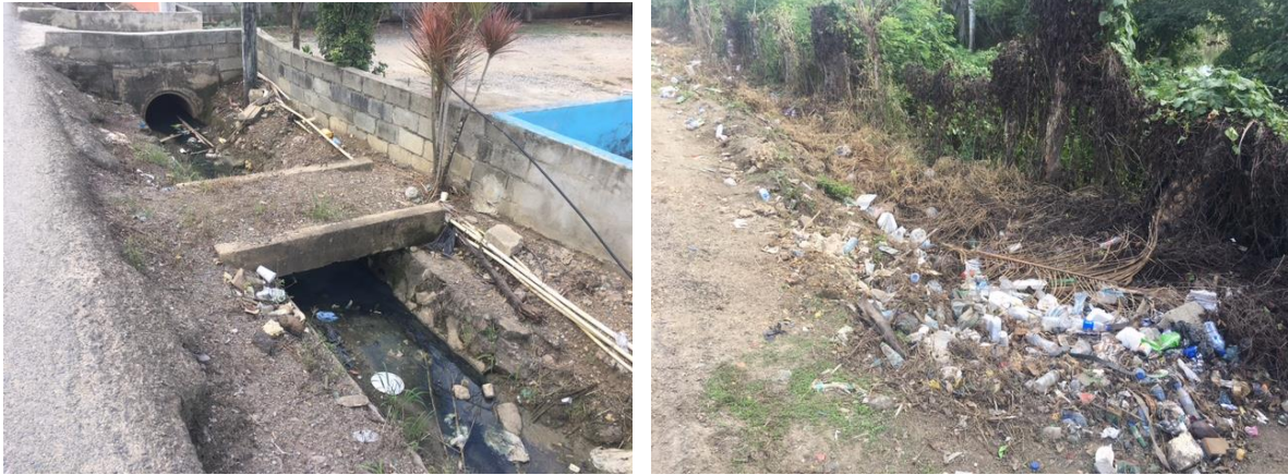
Foto 2. 5 vertidos y residuos en vías cercanas al proyecto
