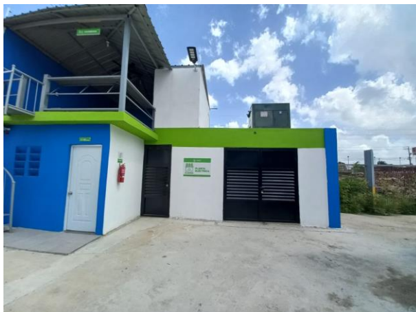
Foto 2.1.12 Cuarto de planta eléctrica de emergencia.
