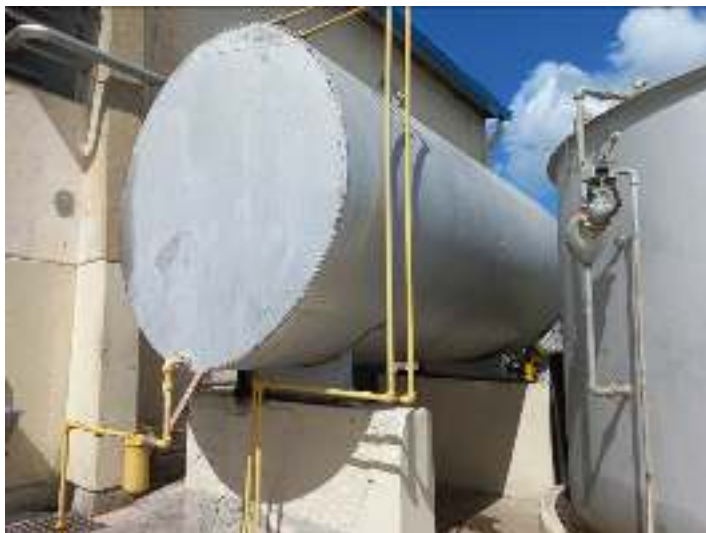
Foto 1.2.8.8-1. Tanque de almacenamiento de diésel (tomada junio 2022).
