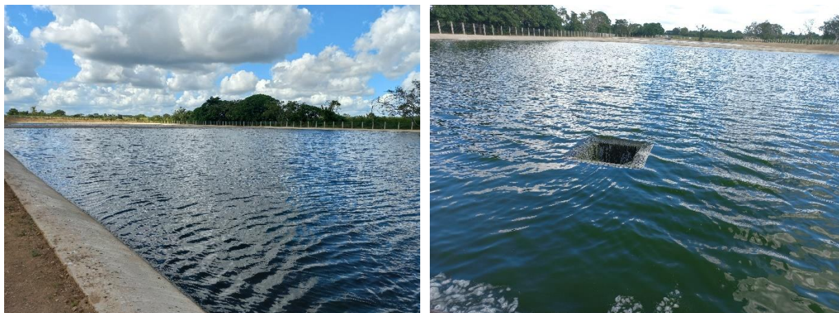
Fotos 7.4-1. Lagunas facultativas para el tratamiento de los efluentes industriales de la Planta.
