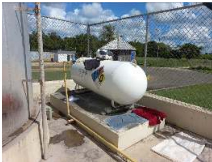
Foto 1.2.8.8-2. Tanque de almacenamiento de GLP (tomada junio 2022).
