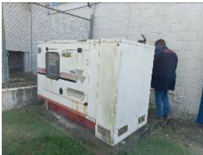
Foto 1.2.8.1-1. Generador de electricidad de emergencia (tomada junio 2022).
