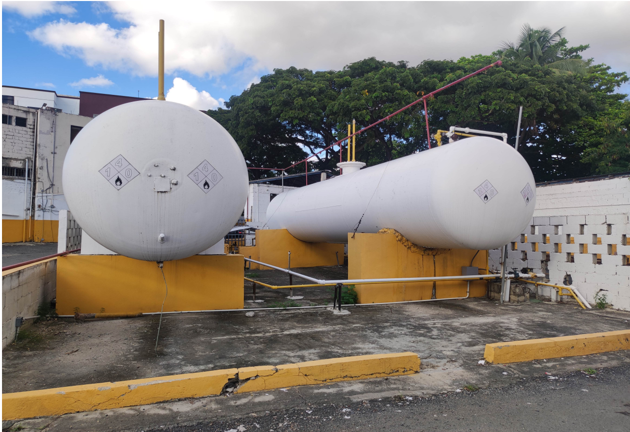
Foto: Área de tanque de GLP. (Tanque No. 2 fuera de uso)
