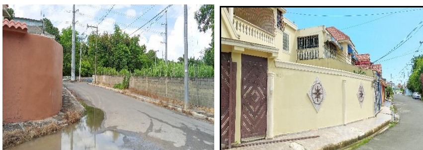
Vista del área del pozo filtrante de descarga de aguas residuales
