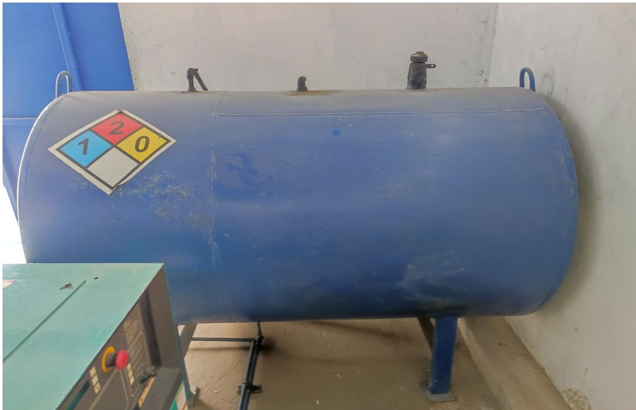
Foto Tanque diesel del generador.
