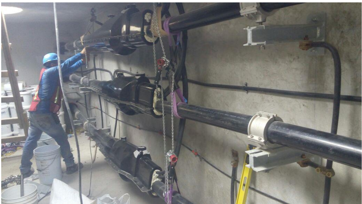
Foto 2.9. Labores de empalmes y posicionamiento de los conductores en un registro
