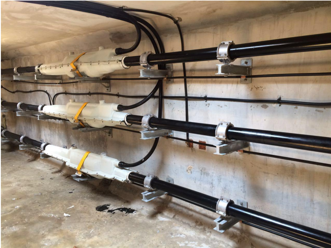
Foto 2.5. Registro de empalme de conductores terminado
