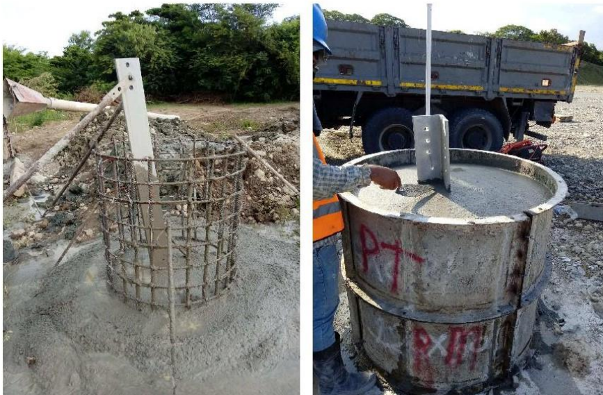
Foto 2.11. Pedestales para torres reticuladas de acero
