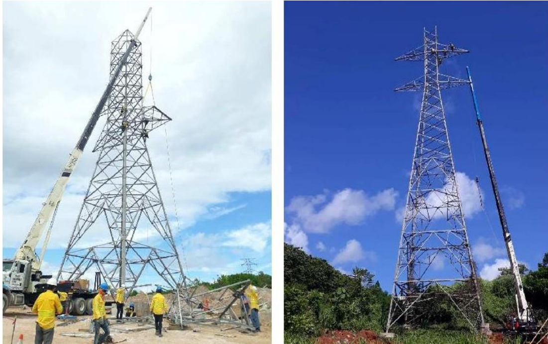
Foto 2.13. Izado de torres con grúas
