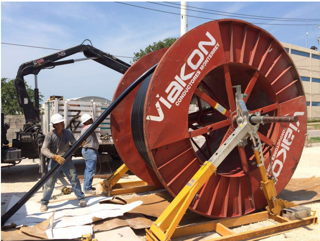
Foto 2.6. Arrastre de conductor en los ductos
