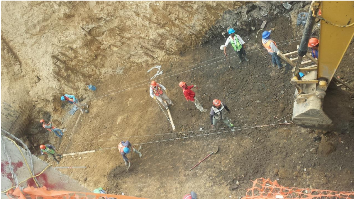
Foto 2.4. Proceso de construcción del registro de empalmes de conductores
