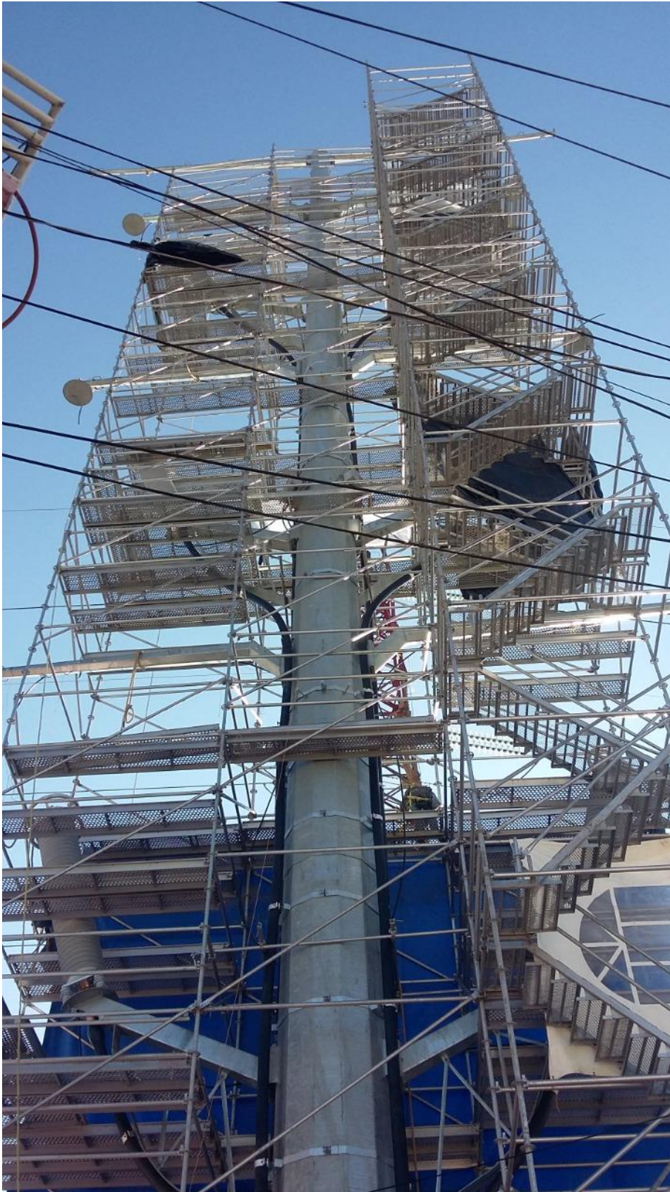
Foto 2.7. Interconexión del segmento soterrado a sistema de conductores aéreos tradicionales
