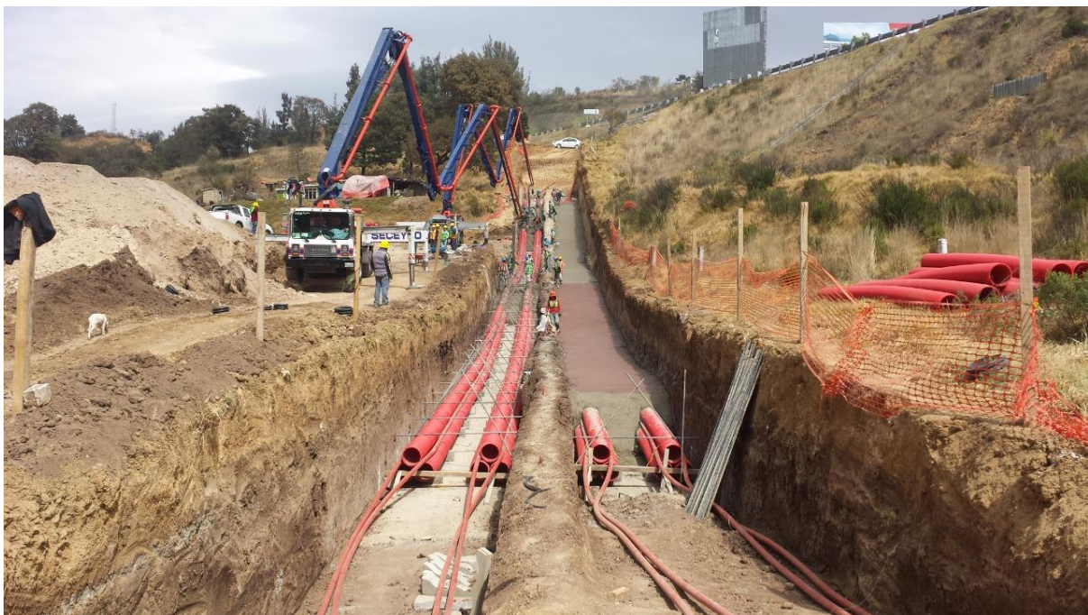
Foto 2.3. Excavación tipo trinchera para líneas de transmisión
