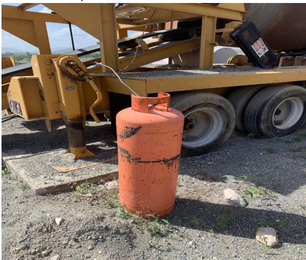
Foto 4. Tanque GLP de 100 litros.
