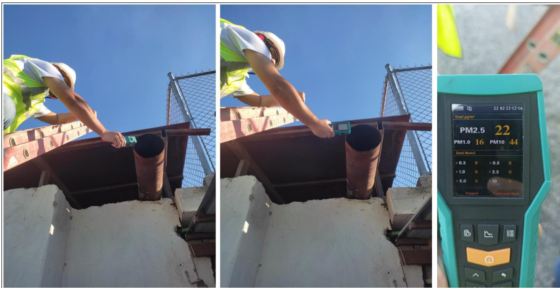
Imagen 5. Muestreo Material Particulado – P2 (Generador Eléctrico)
