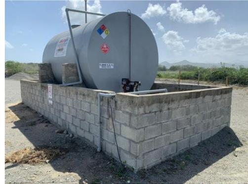
**Foto F4.2** Berma de contención del tanque de almacenamiento de combustible.
