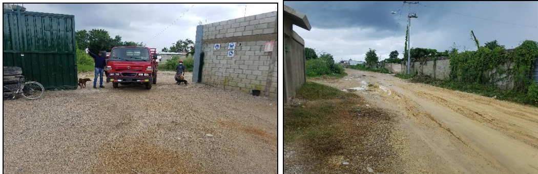
Vista de las vías de acceso principales a la empresa
