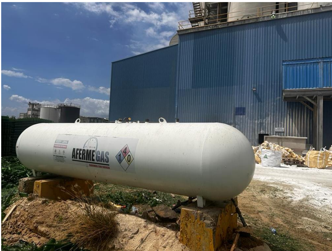
Im-gen 20 - Tanque GLP 1000 Gls Aferme Gas
