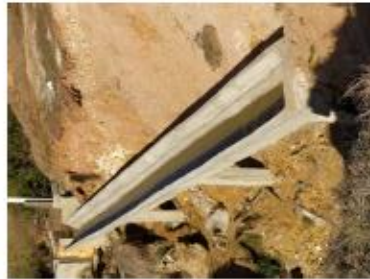
Deslizamiento que destruyó la tubería que conducía las aguas del proceso de cría de peces hacia la laguna de tratamiento.
