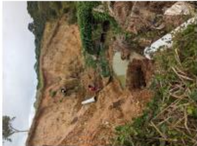
Deslizamiento que destruyó la tubería que conducía las aguas del proceso de cría de peces hacia la laguna de tratamiento.
