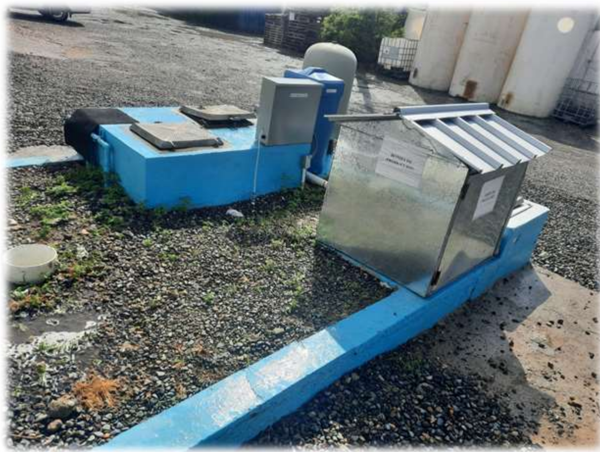
Imagen No. 5. Bomba y un sistema de pretratamiento del agua de la cisterna
