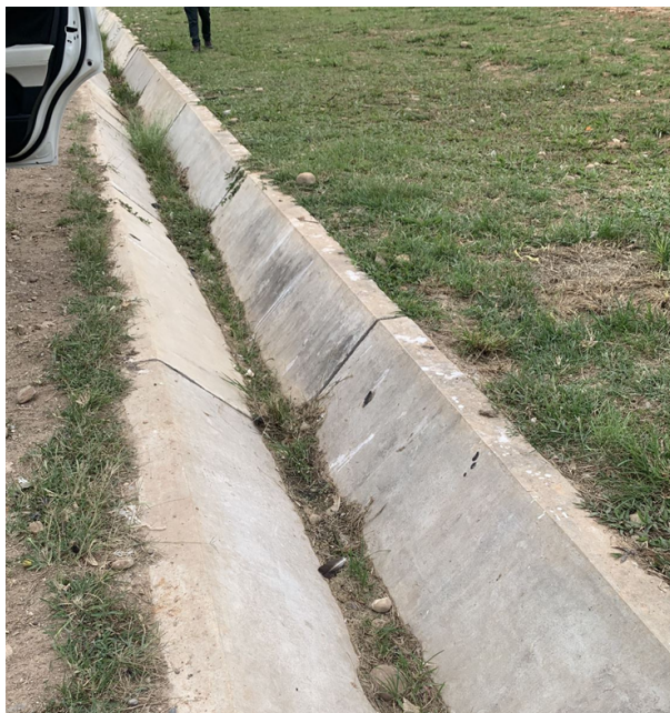
Fuente: Equipo de Expertos de JICA. Relleno Sanitario Moyobamba, Perú. 2022
