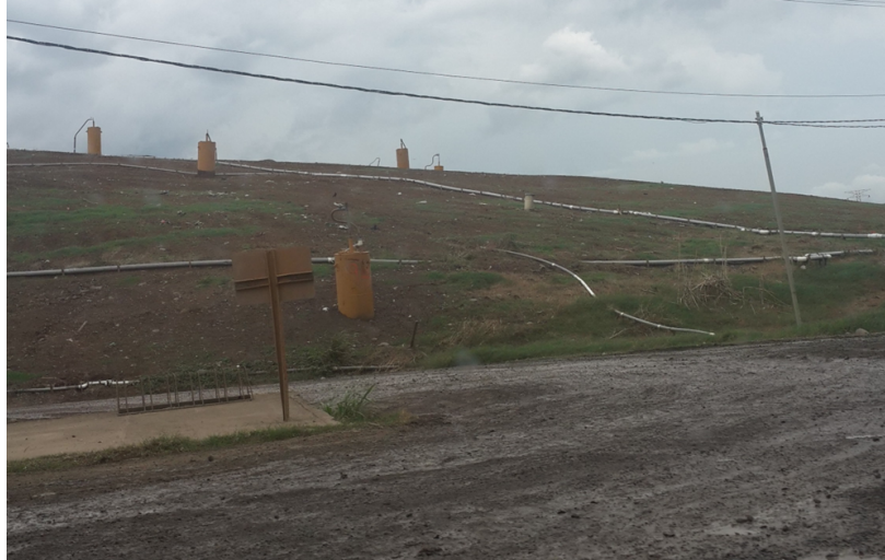
Foto 7. Vista cobertura final y capa vegetal en un relleno
