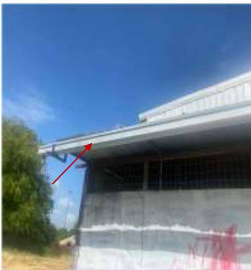
Canaletas de Drenaje
