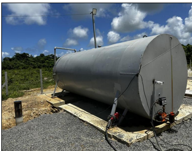
Fotos # 14 y # 15.- Tanque de combustibles y tanque de almacenamiento Agua
