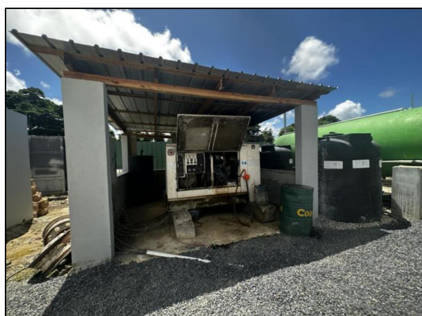
Foto # 16.- Planta electrica de 60 Kw
