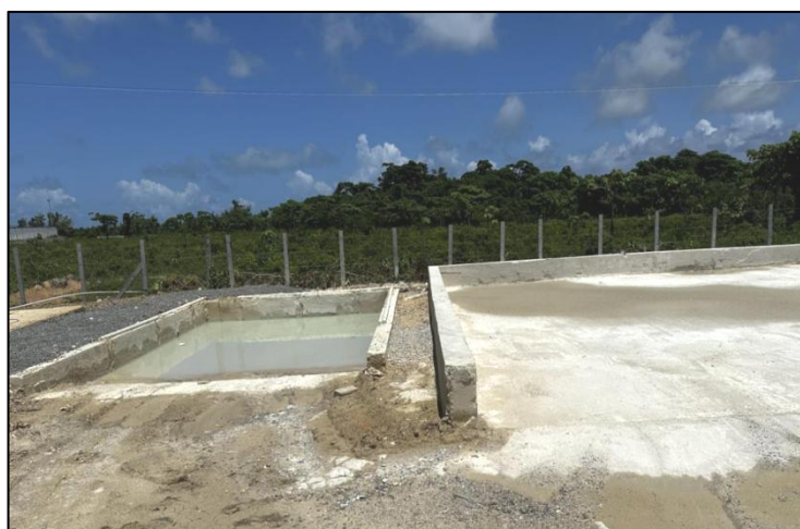
Fotos # 11 y # 12.- Vistas Área de decantación y área de lavado
