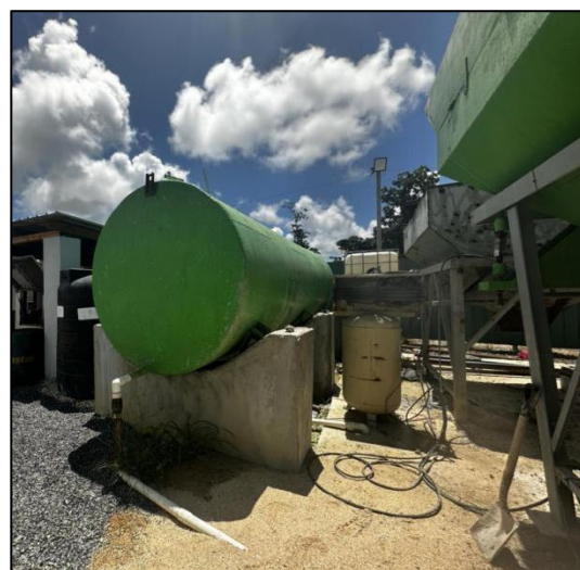
Fotos # 14 y # 15.- Tanque de combustibles y tanque de almacenamiento Agua
