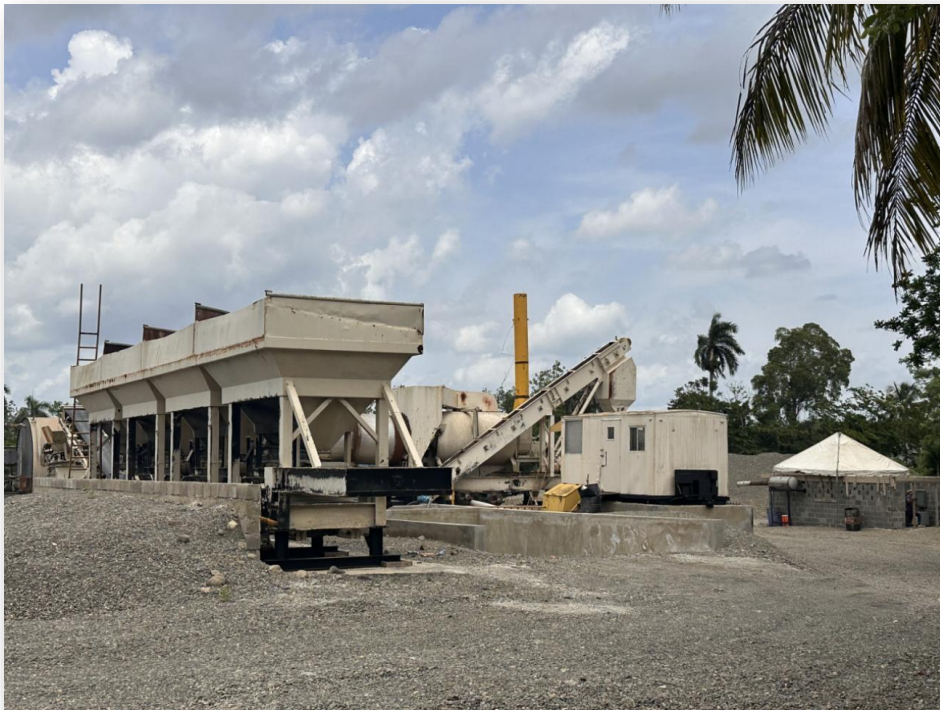
Imagen 11.- Otra vista General de la Planta de Asfalto.
