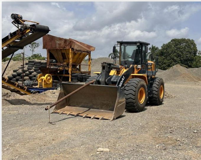
Imagen 7, Imagen 8 y Imagen 9.- Vistas de Planta generadora eléctrica, local del laboratorio y de equipos de la empresa.
