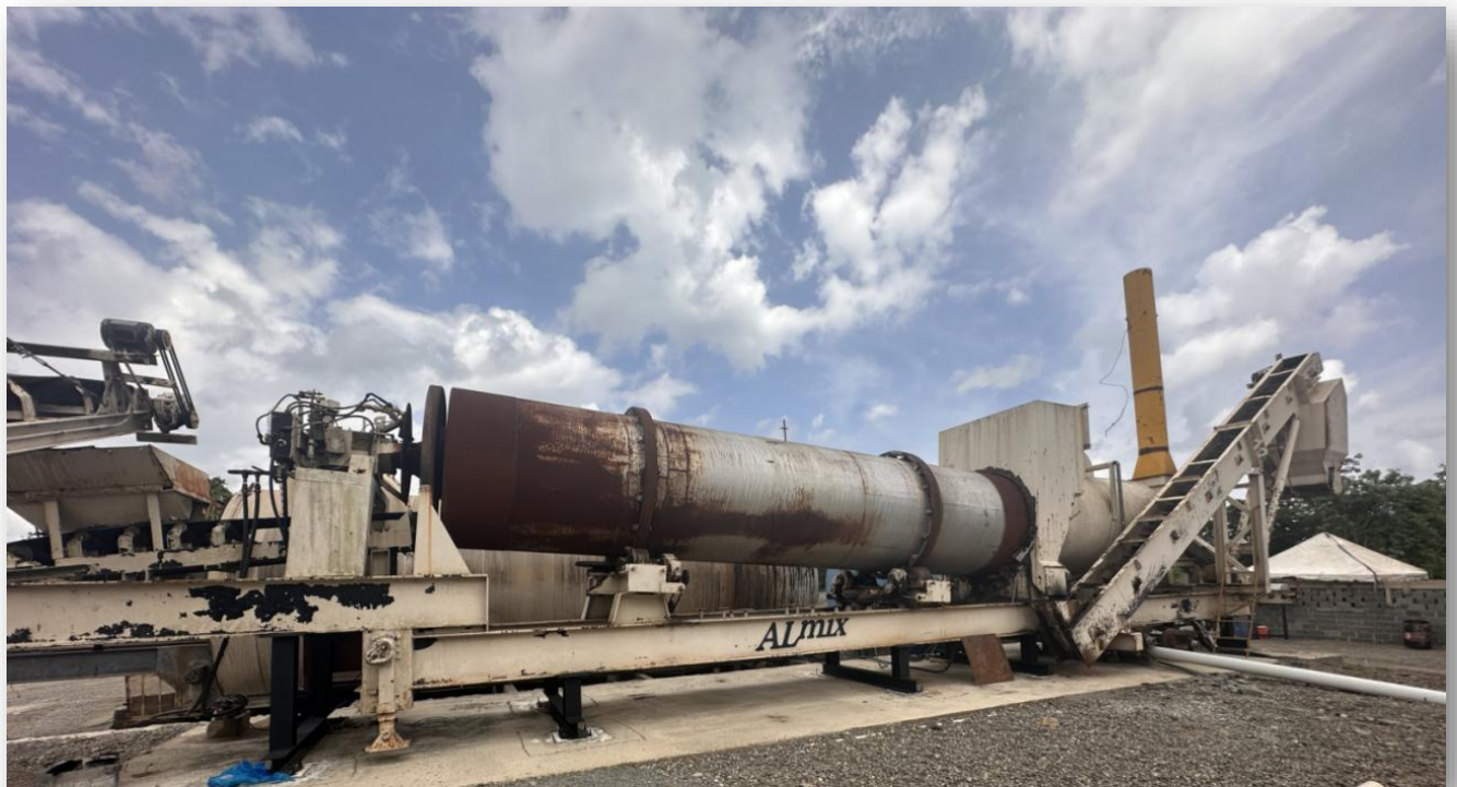
Imagen 3.- Vista General Planta de Asfalto
