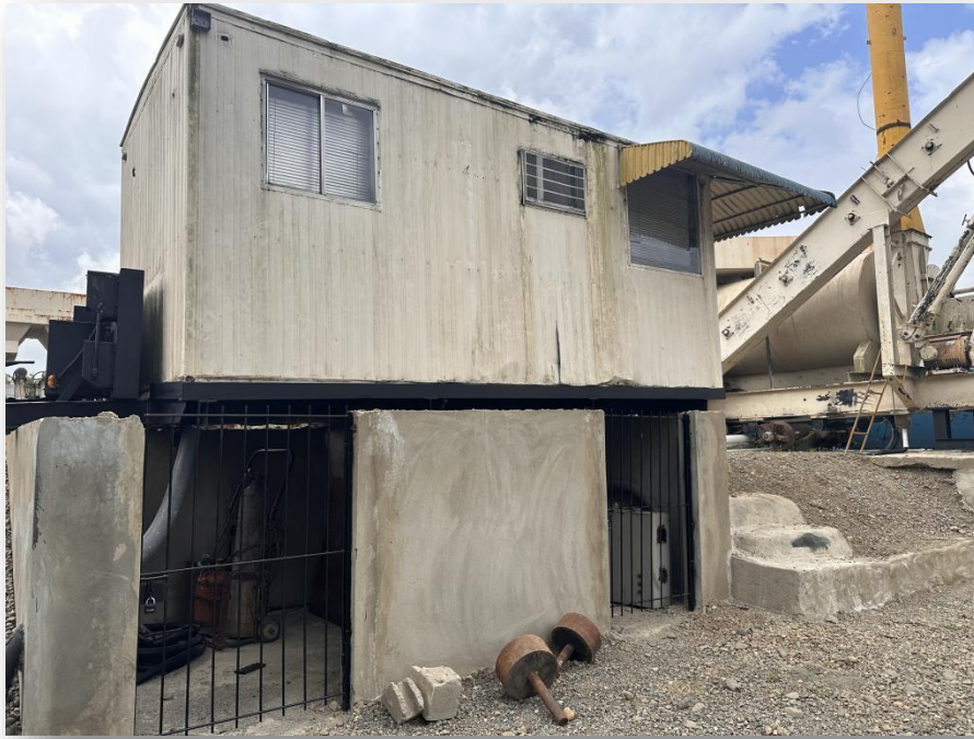
Imagen 2.- Vista del local de la oficina administrativa.
