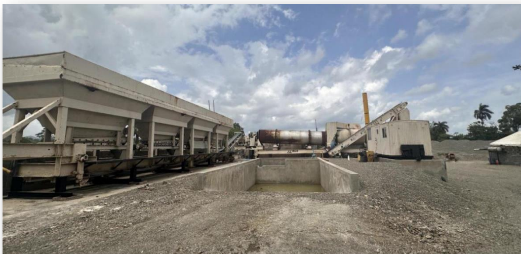
Imagen 1.- Vista panorámica de la planta de asfalto.
