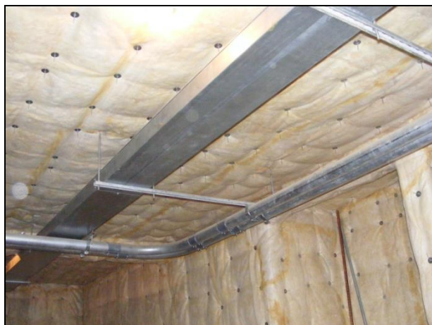
Fotos 7.4-1. Ejemplo de sistema de insonorización instalado en cuarto de generador de electricidad de emergencia.
