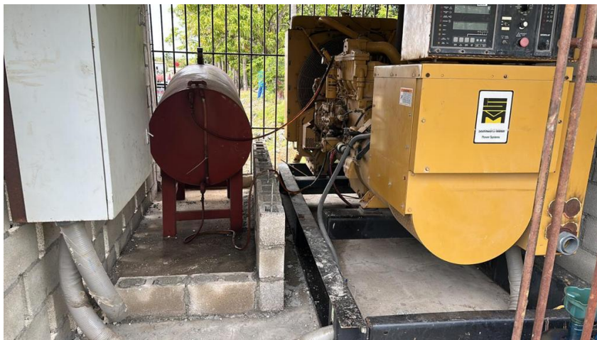
Fotos 7.5-2. Tanque de almacenamiento de gasoil de uso diario de la empresa.
