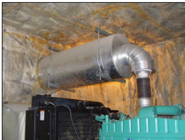
Fotos 7.4-1. Ejemplo de sistema de insonorización instalado en cuarto de generador de electricidad de emergencia.
