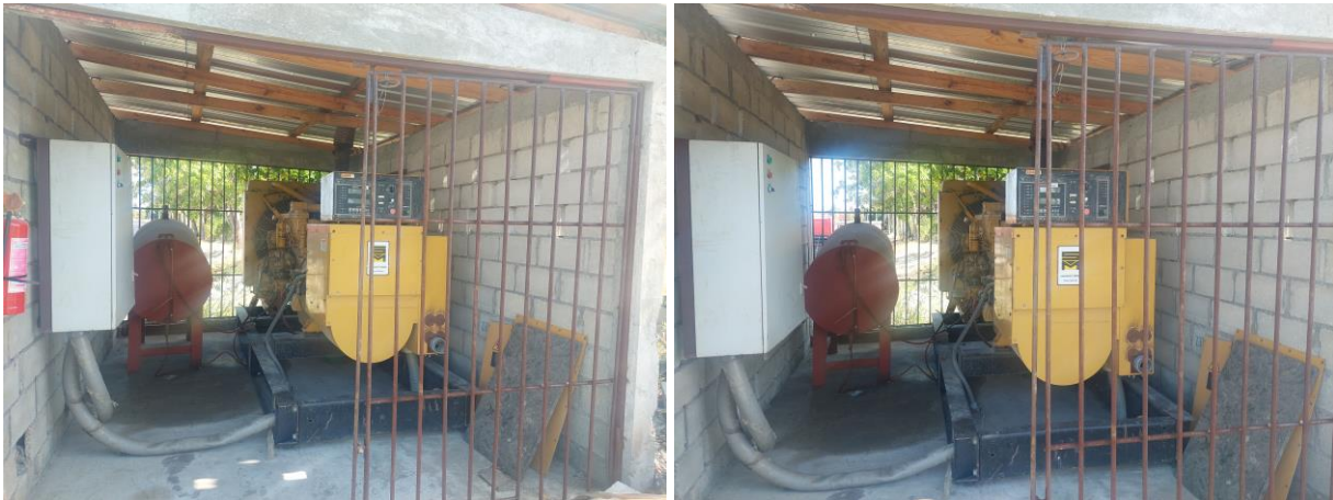
Fotos 3.1.3-1. Generador de electricidad de emergencia de 350 KW.
