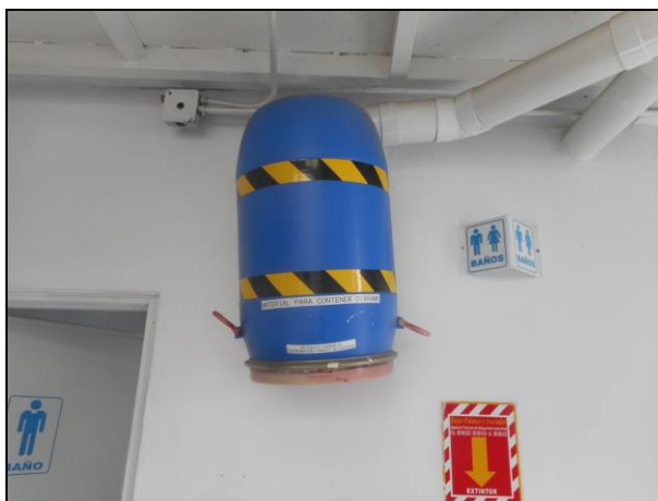
Foto 7.5-3. Tanque colocado próximo a depósitos de combustible con material para contener derrame.
