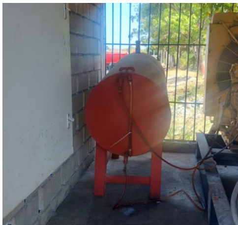
Foto 3.1.3-2. Tanque de almacenamiento de diésel de uso diario que abastece al generador de electricidad.
