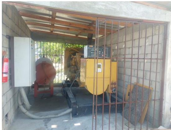
Foto 5.1.1-2. Generador de electricidad de emergencia instalado en el proyecto
