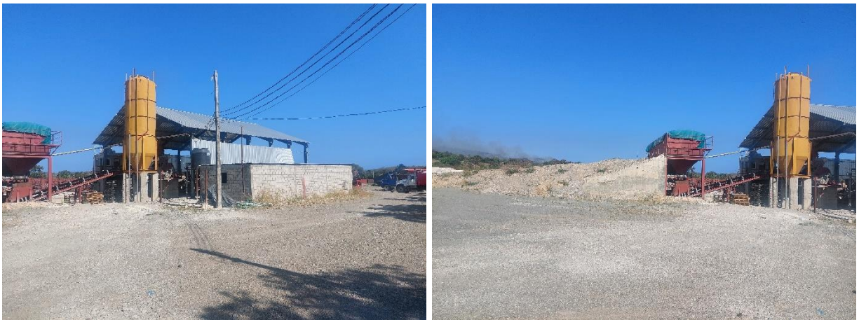
Fotos 1.2.4-3. Silo de cemento instalado en el proyecto.
