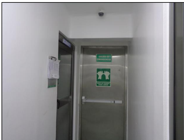
Fotos 7.8-2. Ejemplo de carteles para identificar las rutas de evacuación y salidas de emergencia a instalar en la bloquera.
