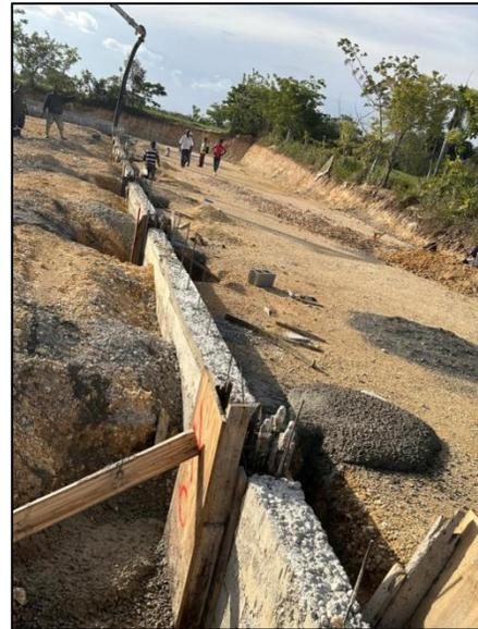
Foto 8 y Foto 9.- Vistas que muestran momentos durante la construcción de los bordillos.
