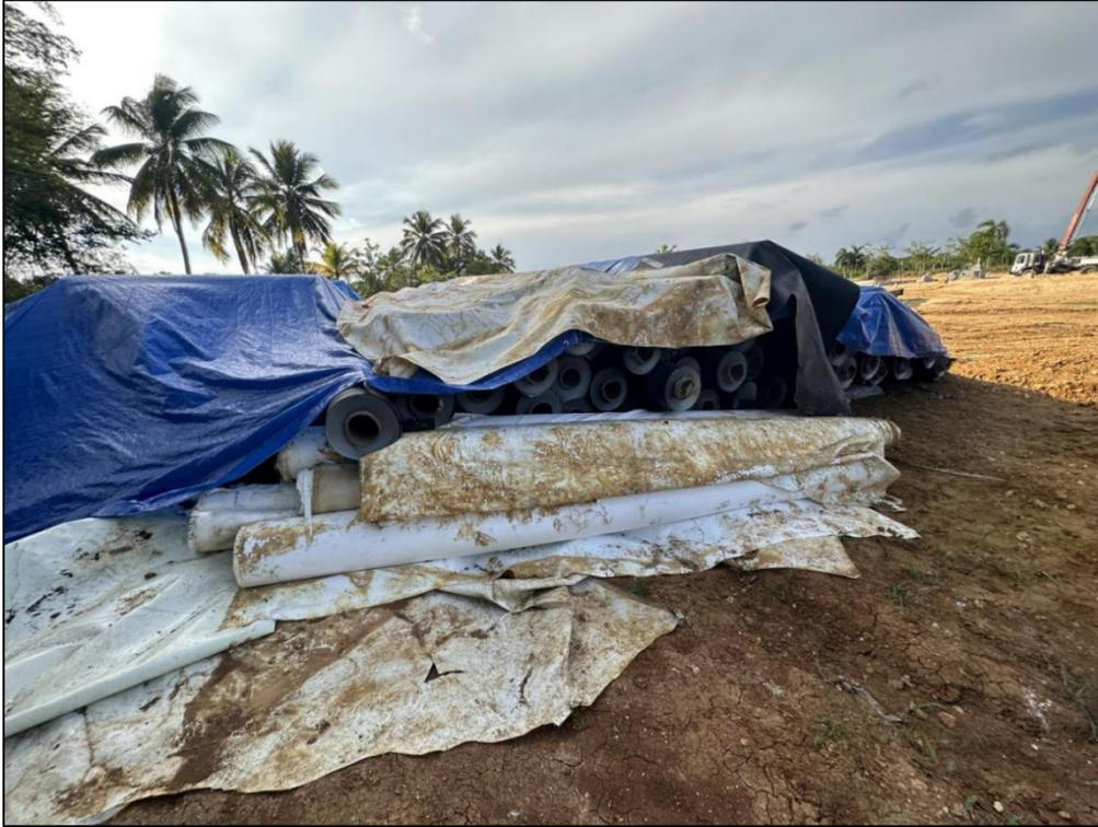
Foto 3 y Foto 4.- Vistas rollos de mallas poliéster con la que se prepara membrana asfáltica.
