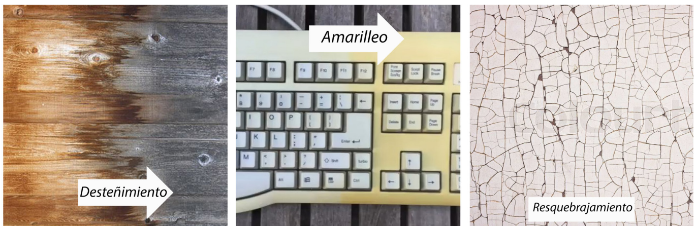
Figura P11-1. Signos de degradación en materiales inducida por la luz solar UV.
