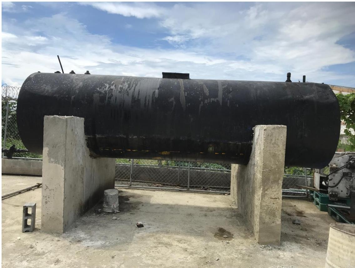
Imagen del tanque de almacenamiento de fueloil
